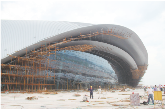
近日,中建八局广西分公司承建的南宁机场项目B幕墙架子顺利拆除。远远望去,机场航站楼入口双层屋面配以弧形蓝色玻璃幕墙,宛若双眼皮下的蓝色眼睛,灵动富有韵味。(闫小荣/摄影报道)
