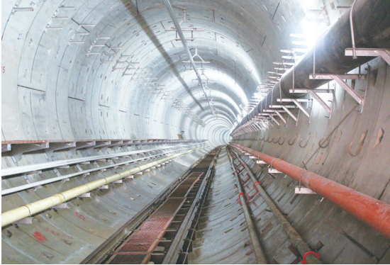
近日,中建土木轨道分公司深圳地铁9号线9101标项目部,在国内首次应用盾构隧道预埋滑槽技术,将各种支架直接安装在滑槽上,比传统工艺工效提高大约3倍。(邱杰/摄影报道)
