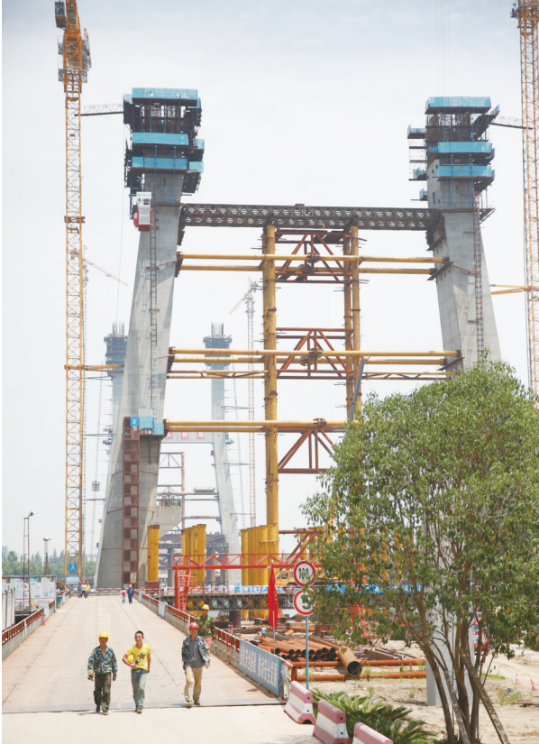
近日,中建三局三公司承建的武汉四环线汉江特大桥主墩支架上横梁施工完成。该桥主桥全长714米,为双塔双索面预应力混凝土斜拉桥,北塔高130.1米,南塔高126.1米。作为武汉四环线的控制性工程,该桥预计2015年底完工。(李健/摄影报道)
