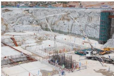
近日，中建电力陆丰项目1号常规岛第一罐混凝土顺利浇筑，该岛整体筏基正式开工。（田娟娟/摄影报道）
