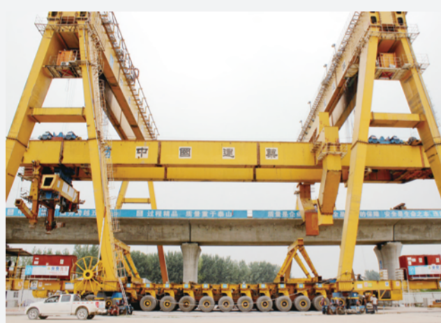
近日，中建土木公司河南中牟制梁场TLJ900型架桥机在完成第668跨箱梁架设任务后，经架桥队4天4夜的轮班作业，历经7.5公里爬行到达梁场，顺利完成调头，正式开始大里程方向的架设工作。（沈广年/摄影报道）
