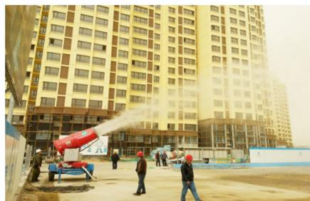
近日,中建二局三公司唐山丰润中建城项目使用大口径“喷雾炮”,其射程在40米左右,可360度旋转,喷出的雾团状水雾能有效控制施工现场扬尘。(吴兰军 赵文革)
