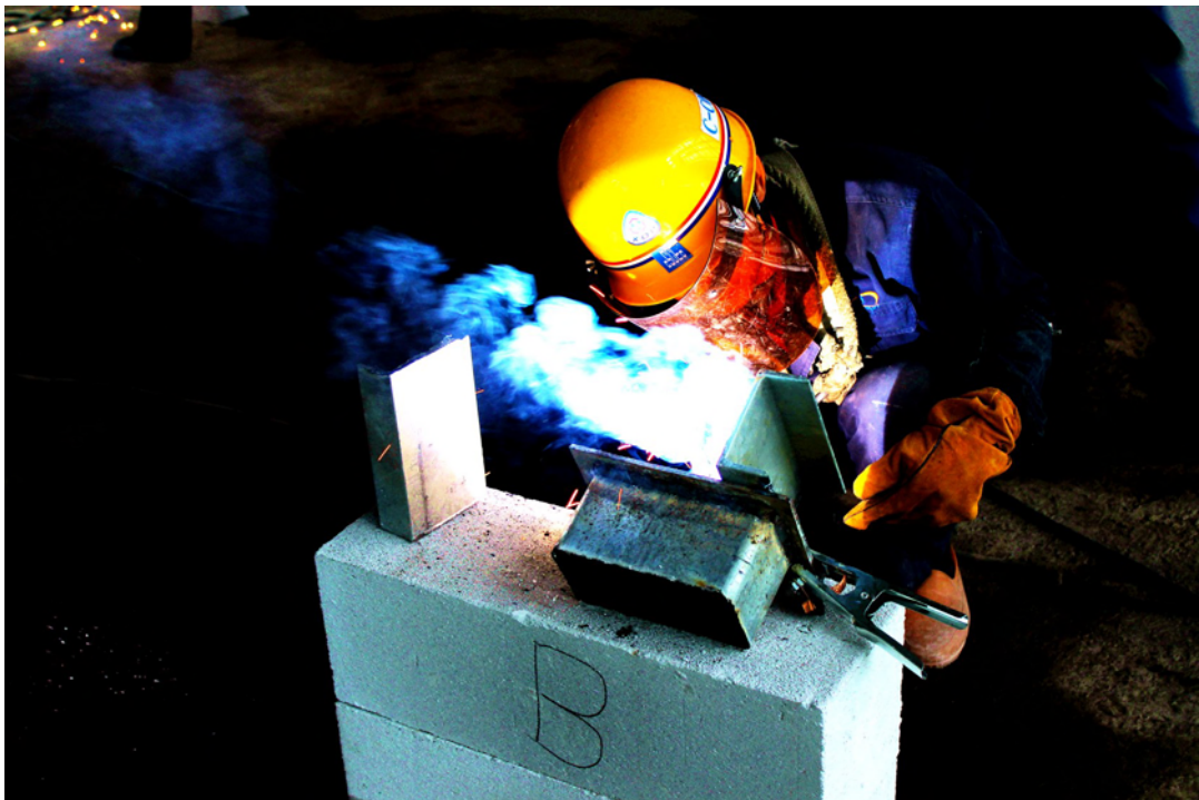
近日,中建不二幕装饰工程有限公司在福州泰禾城市广场项目举办“超英杯”电焊操作竞赛,比赛从耗时、耗材及成品质量三个方面进行考评,营造了“比学赶超”的良性竞争氛围。(黄兵)
