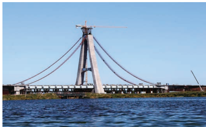
近日,中建六局桥梁公司松原市天河大桥项目南汉桥猫道的整体吊装施工完成。该大桥南汉桥边跨为100米,猫道采取桥面预制,整体吊装的方法进行施工。(袁长剑)
