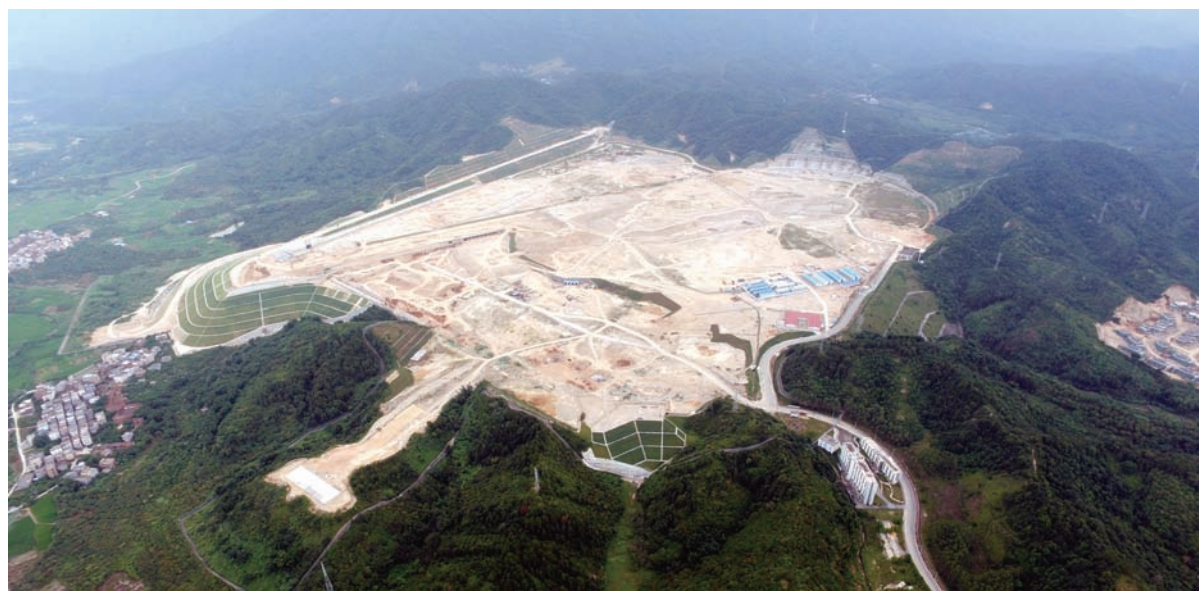
中建八局一公司参建的广州香港马会项目点多面广、交叉施工频繁、管理复杂。近日,该项目将基于BIM模型的无人机技术应用于指导总承包管理,将现场航拍的人员、材料、机械布置及施工进度等影像与BIM施工模拟图进行对比分析,进行实时管理,提高了工作效率。(袁成太 赵生智)
