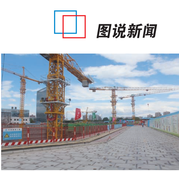
近日,中建二局北京分公司北京丽泽金融商务区F02、F03地块项目部,用可反复使用6至8次的自制混凝土块铺装完成约3340平方米的路面。(张敬宜)
