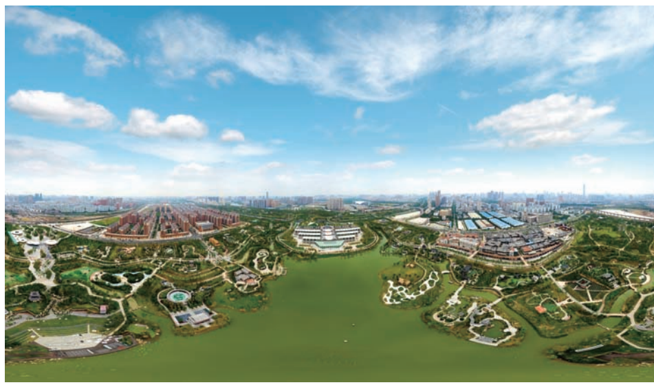
近日,第十届中国国际园林博览会在武汉开幕,由中建三局承建的武汉园博园园林艺术馆、长江文明馆等工程正式对外开放。(程超 薛舒雯)
