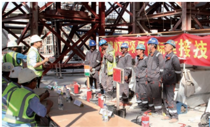
近日,“中建MTB项目国际焊工技能大赛”在阿布扎比国际机场项目工地举行,中印焊工以“单边焊双边成型”为内容,比质量、拼速度、看成型,最终中国焊工王星摘得桂冠。大赛增进了中印焊工之间的文化和技艺交流,提升了项目外籍务工管理水平。(孔繁荣 曾骥)
