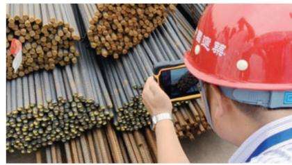
材料员正手持智能计数终端拍摄一捆钢筋端头截面以获得每捆钢筋的数量。
