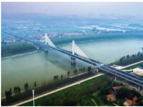
近日,由中建三局投资6.78亿元建造的湖北首座矮塔单面双排斜拉索桥——武汉中法友谊大桥建成通车。该桥双向6车道,全长4.39公里。(程超 吕晓娟 尹章东)
