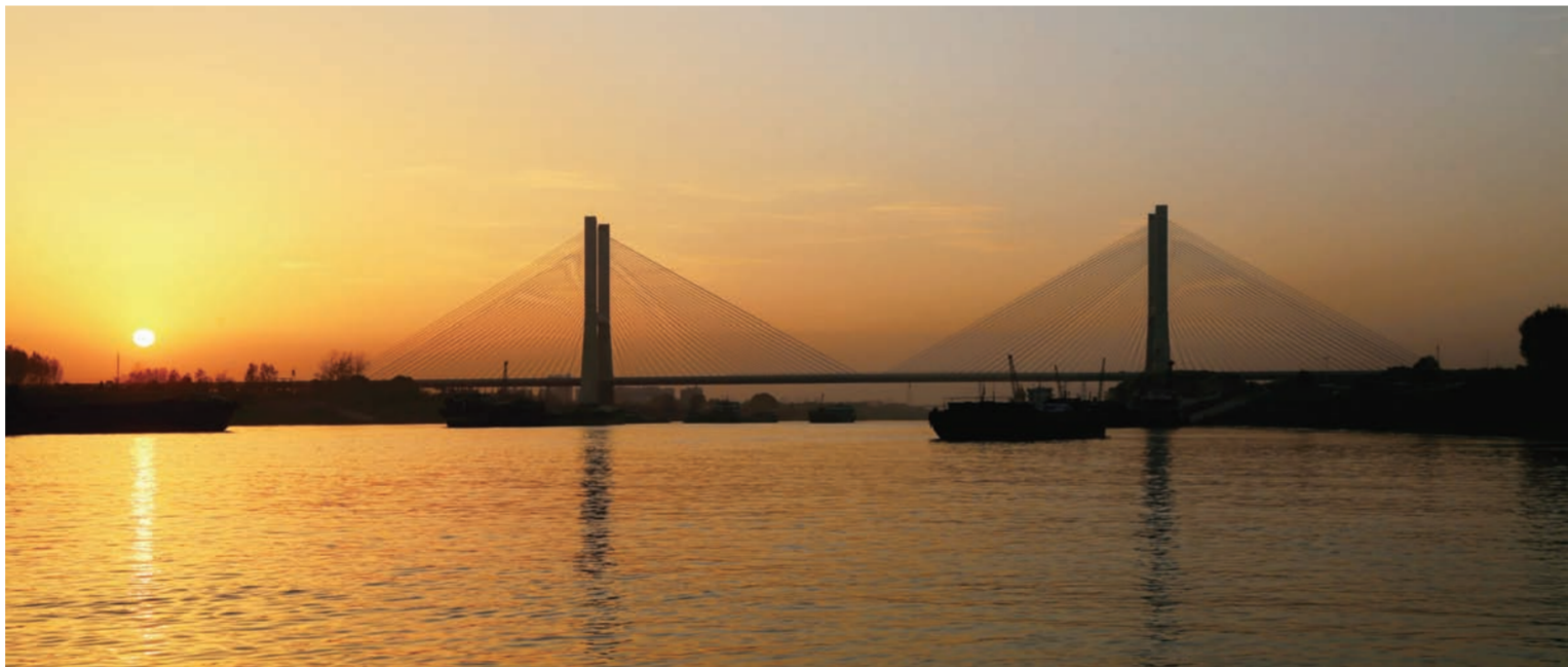
近日,中建三局三公司、中铁大桥局联合承建的亚洲最宽混凝土现浇桥梁——武汉四环线汉江大桥贯通。该桥设计为双塔双索面预应力混凝土斜拉,主塔高130米,主跨360米,主桥全长714米,引桥长195米,宽44米,设计标准为双向8车道高速公路。(程超 黄卉)
