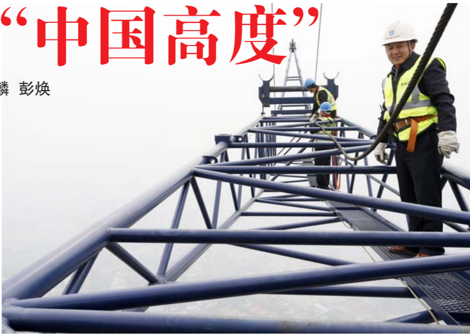
徐彬(右一)站在武汉中心项目近500米高的ZSL380重型塔吊塔臂上指挥塔臂折起
