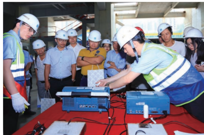
钢结构装配式施工工艺区、装配式机电安装工艺区、轻质隔墙施工工艺区等实体样板随参观有序呈现……5月13至14日，中建二局一公司深圳分公司在半岛城邦项目现场承办深圳市科技创新观摩活动，千余同行参加。(王义生 刘超群)
