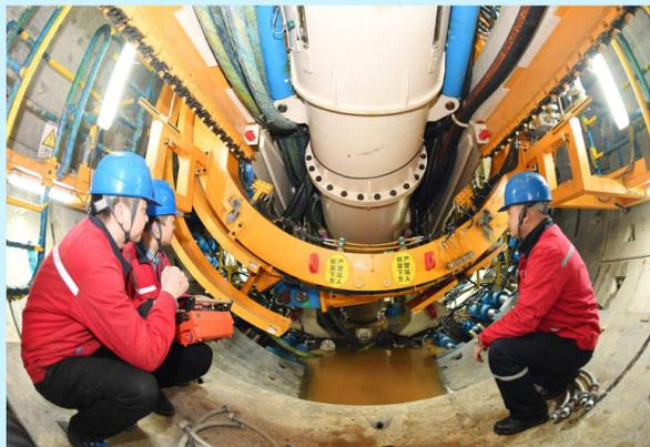
近日,中建股份、中建五局、中建七局投资建设的长沙地铁6号线二标首台盾构机始发。项目使用的“信和51号”盾构机为土压平衡盾构机,开挖直径达6440毫米,是目前长沙在建地铁中直径最大的盾构机。长沙地铁6号线线路全长48公里,共设地铁站34座,中建承建的部分线路总长11.38公里。(唐骞、曾祺、王志伟)
