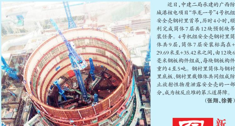
近日,中建二局承建的广西防城核电项目“华龙一号”4号机组安全壳钢衬里首吊,历时4小时,顺利完成筒体7层共12块预制块吊装任务。4号机组安全壳钢衬里筒体共9层,筒体7层安装标高在+29.69米至+35.42米之间,由12块6毫米钢板构件组成,每块钢板构件重约4至5吨。钢衬里筒体与钢衬里底板、钢衬里截锥体共同组成防止放射性物质泄露安全壳的一部分,成为核反应堆的第三道屏障。(张翔、徐菁)
