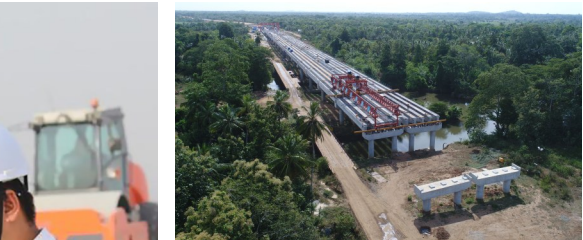
斯里兰卡南部高速公路项目
